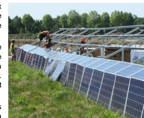
Photographie 26 : Montage des éléments de structures de la centrale
