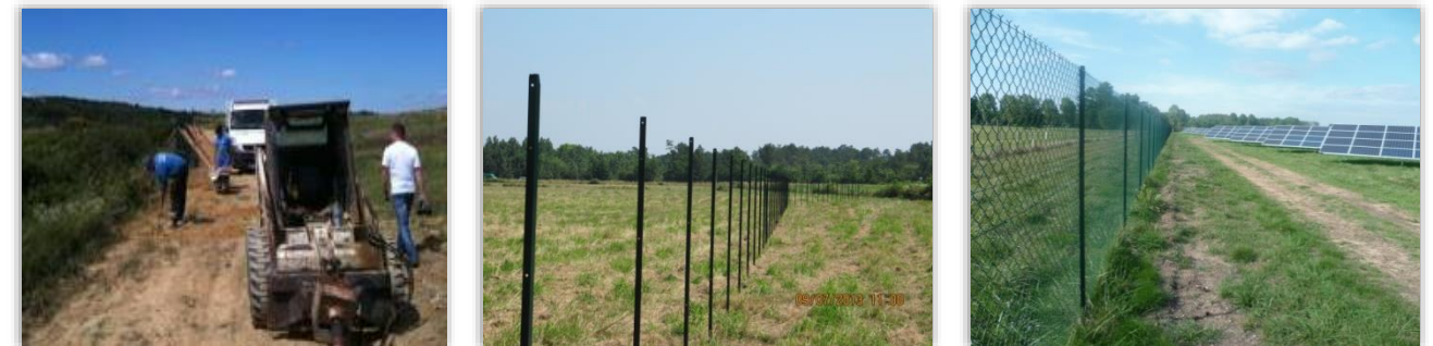
Photographie 14 : Mise en place de la clôture (pose des ancrages, des piquets et du maillage)
