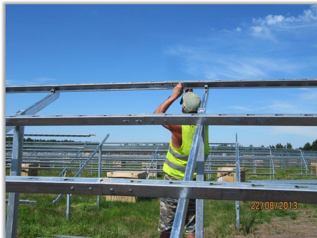
Photographie 6 : Systèmes de fixation pour installation photovoltaïque
