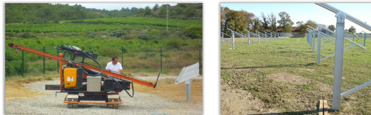
Photographie 19 : Machine de battage des pieux à gauche et structures porteuses de panneaux à droite
