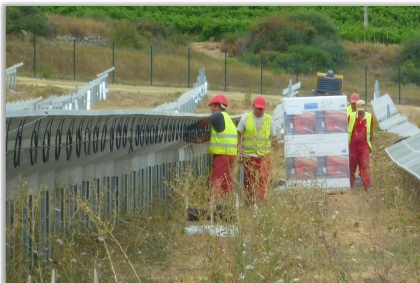
Photographie 11 : Câblage et interconnexion des modules photovoltaïques
