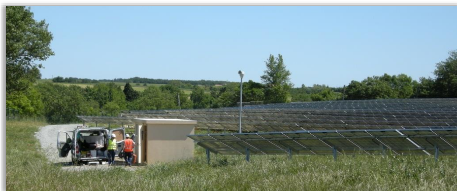
Photographie 23 : Opération de maintenance
