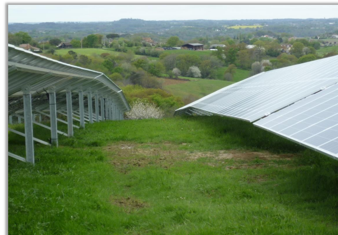
Photographie 7 : Adaptation des tables à la topographie
