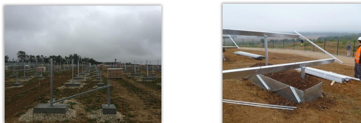
Photographie 20 : Pose de fondations lourdes
