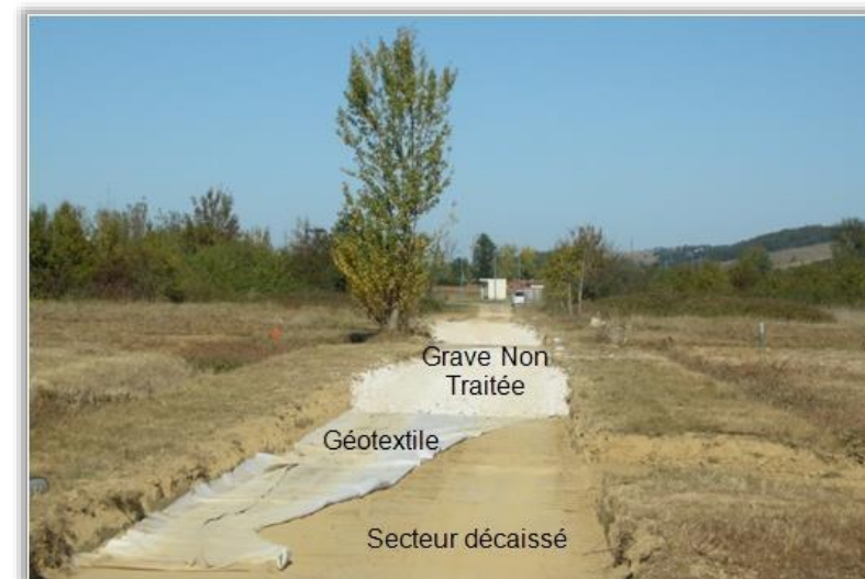
Photographie 16 : Mise en place d'une voie engins (lourde)
