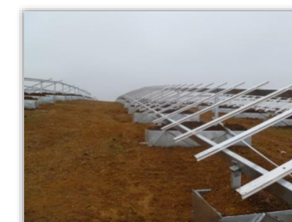
sur supports lestés
