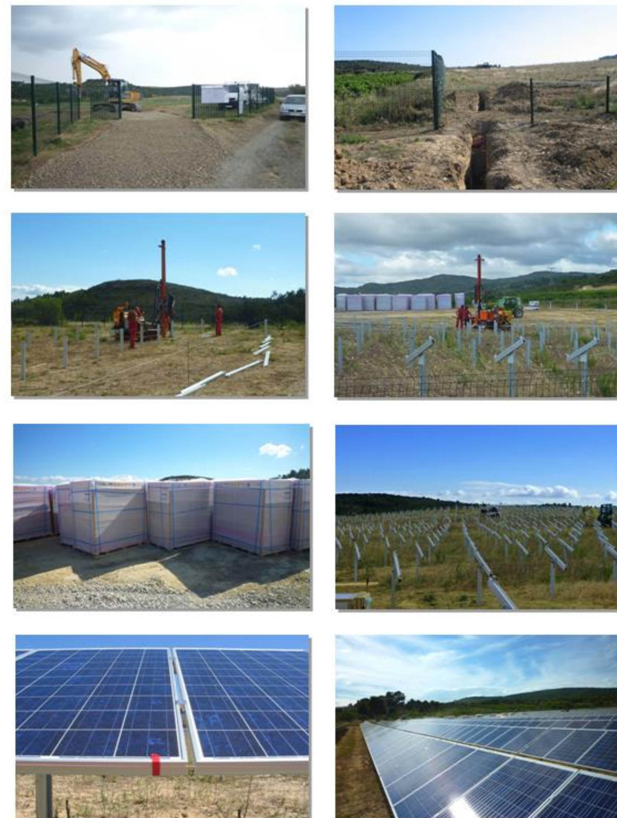
Photographie 22 : Présentation des différentes étapes du chantier - Source : LUXEL
