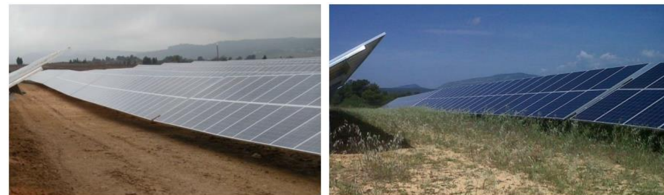
Régénération spontanée de la végétation après travaux Parc solaire de Thézan-les-Corbières (Aude) : ancienne décharge entièrement remodelée en janvier 2014 à la fin des travaux, et en juin 2014
