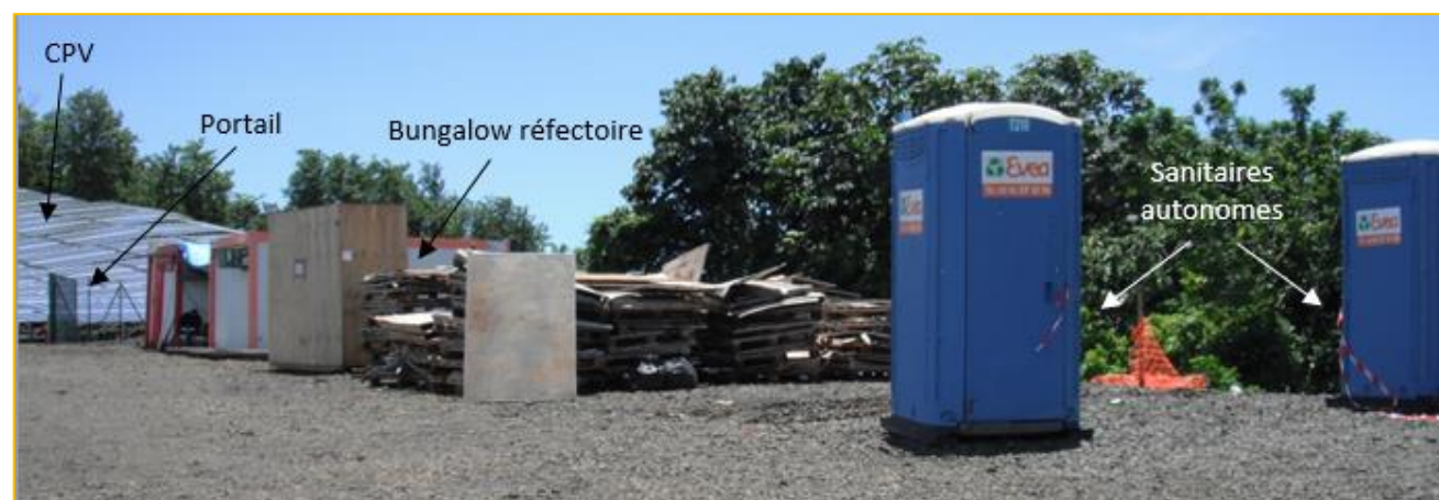
Photographie 28 : Organisation base de vie d'un chantier de CPV
