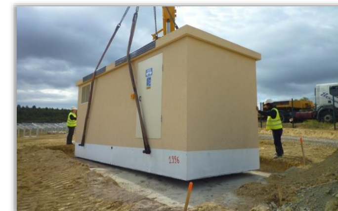
Figure 11 : Schéma de dépose des postes préfabriqués (Source : Transfix)
