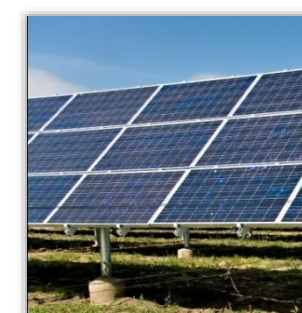
sur plots béton
